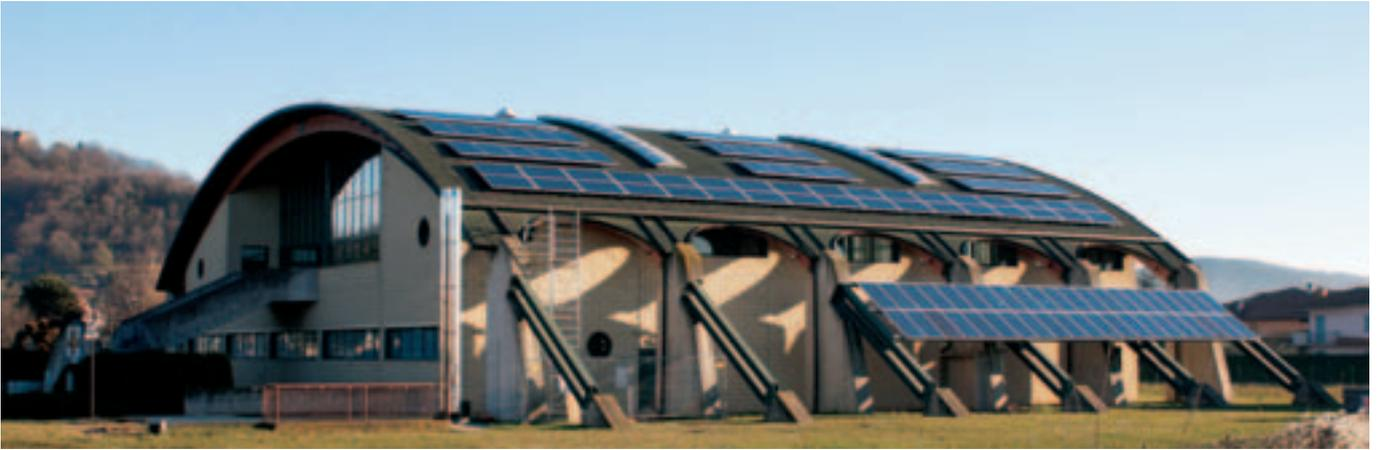
con moduli fotovoltaici di tipo cristallino, realizzati in Europa, con densità di potenza di almeno 140 W/m<sup>2</sup>, inverter realizzati in Europa con efficienza massima pari ad almeno del 93%.
